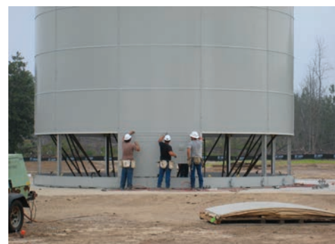
Standpipe - elevado do nível do solo
