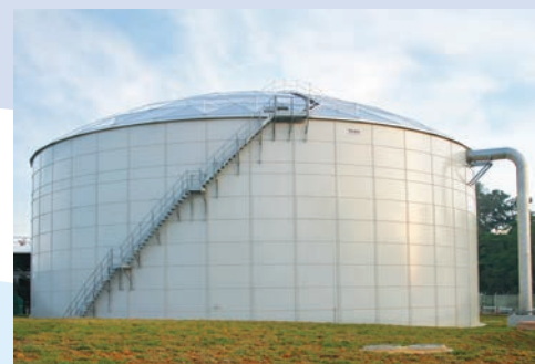
Construção RTP - Armazenamento de água pura 4,5 milhões de galões/ 17.000 m 3
