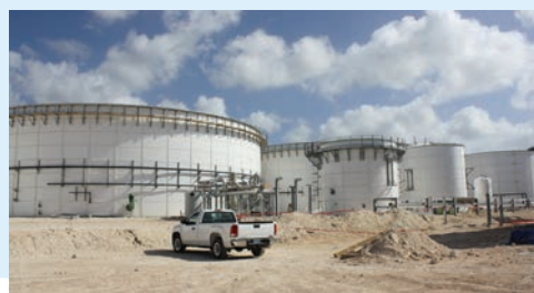
Instalações para água e efluentes
