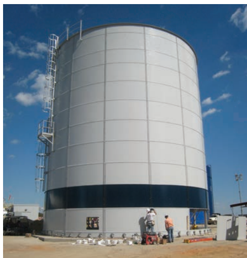
Fornecimento de energia - Água de processo
