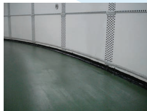
Interior do tanque municipal XL de armazenamento de água Anel de base com piso de concreto
