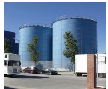
Tanques digestores anaeróbicos
