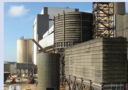
Construção de tanques RTP aparafusada, solda no campo e híbrida
