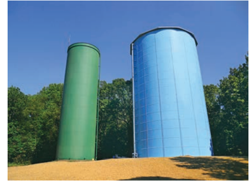
Standpipe soldado no campo
